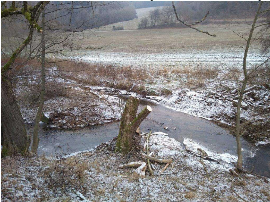
Zustand nach Beseitigung des Hindernisses und Rückschnitt einer Weide.
