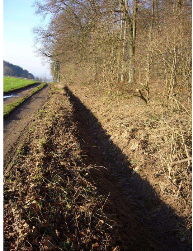
Grabenwiederherstellung an Waldrand durch Aushub & Rückschnitt Aufwuchs (Stadt Reichelsheim)
