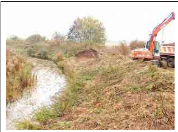
Bild 3: Beseitigung des Dammes
