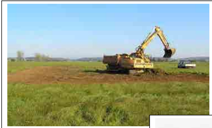
Während der Baumaßnahme
