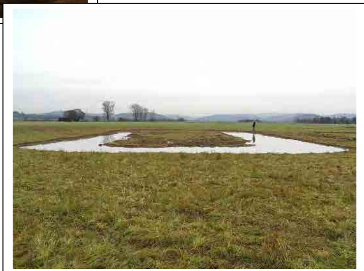
Fertig gestellte Flutrinne, schnell mit Wasser gefüllt
