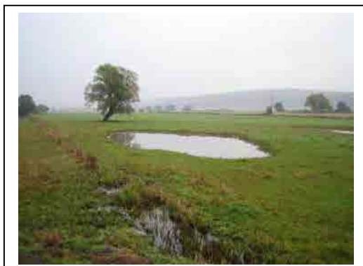
Bilder: Umgestaltung des „Sackteichs“ während der Baggerarbeiten (o.l.) und nach Fertigstellung (o.); neu angelegte Flutmulde (l. u.)
