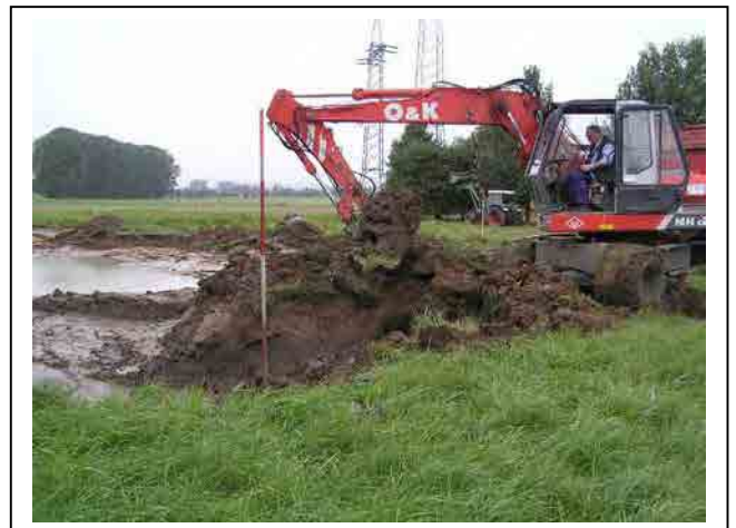
Bild: Während der Bauarbeiten
