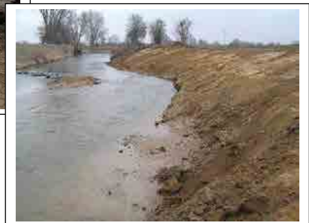
Bilder: Das linksseitige Ufer der Nidda wird abgeflacht und neu profiliert
