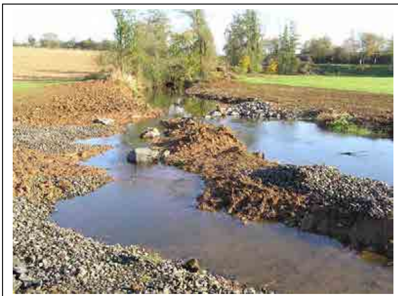
Bilder: Die 2004 bis 2006 renaturierten Fluss- und Auenbereiche haben sich in kurzer Zeit funktionell und optisch sehr harmonisch entwickelt. Die 2007 durchgeführten Maßnahmen befinden sich noch im „Rohzustand“ und werden sich erfahrungsgemäß ohne weiteres Zutun innerhalb der nächsten ein bis zwei Vegetationsperioden begrünen.
