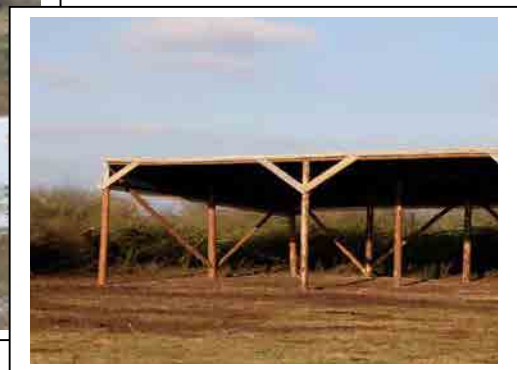
Bilder: links die „Kuhweide“ von Unter-Widdersheim, rechts der Weideunterstand im Bau
