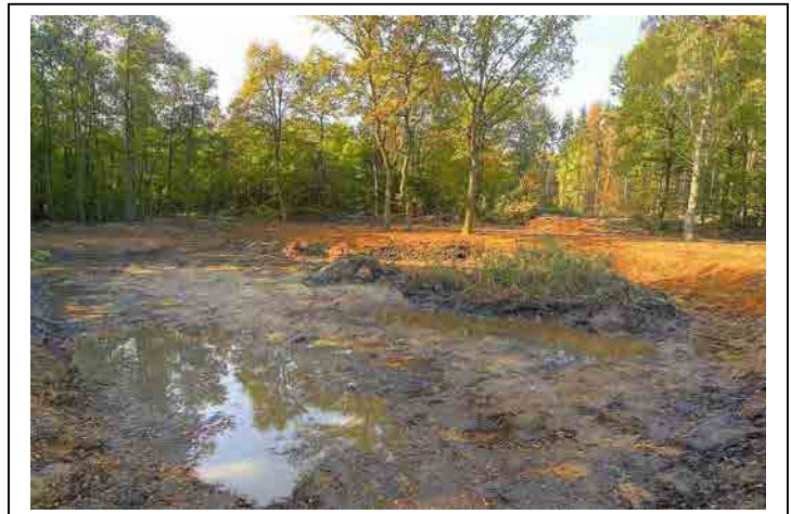
Bilder: Der Teich zu Beginn, während und nach Abschluss der Sanierungsarbeiten
