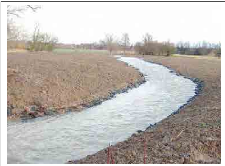
Bild 1: Durch das Umgehungsgerinne ist ein neuer Seitenarm der Wetter entstanden, der von Fischen und sonstigen Gewässerorganismen ohne Probleme auch flussaufwärts überwunden werden kann.
