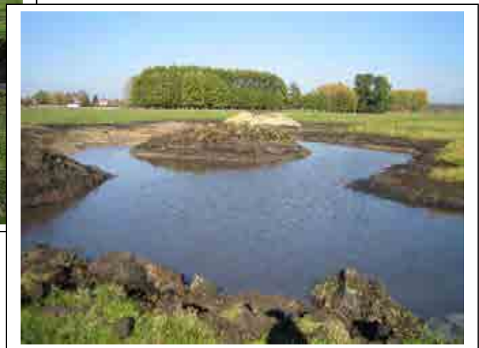
Bilder: links während der Bauphase, rechts der fertige Flachwasserteich
